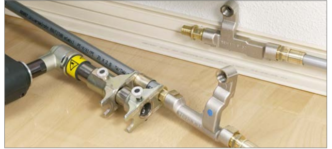
Şek. 20-28 RAUTITAN SL apraz bağlama fittingde 20 ölçüsünde geçme manşon bağlantısı
