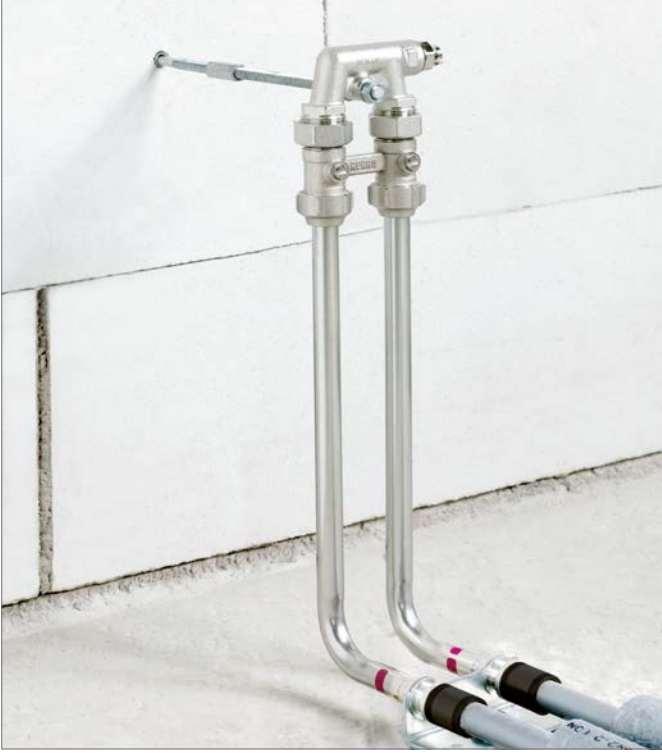
Şek. 19-10 Havalandırıcılı montaj köprüsü, zeminden bağlantı montaj örneği
