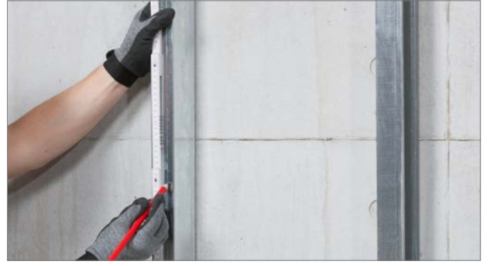
Şek. 6-34 Kurulum yüksekliğinin işaretlenmesi
