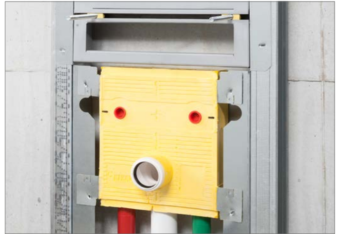
Şek. 6-41 240 mm genişlikte bir sıhhi kutunun krimplenmesi
