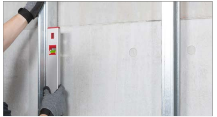
Şek. 6-31 Alçıpan profilinin hizalanması
