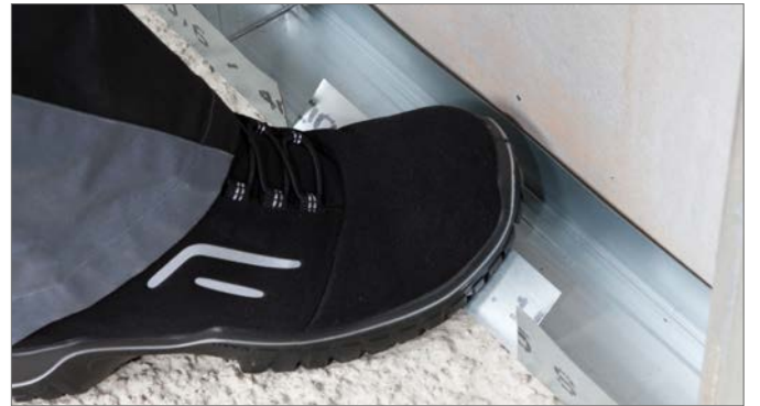
Şek. 6-33 Kesilen UW profilinin bükülmesi
