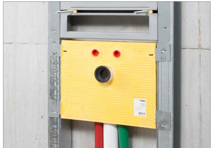
Şek. 6-42 350 mm genişlikte bir sıhhi kutunun krimplenmesi
