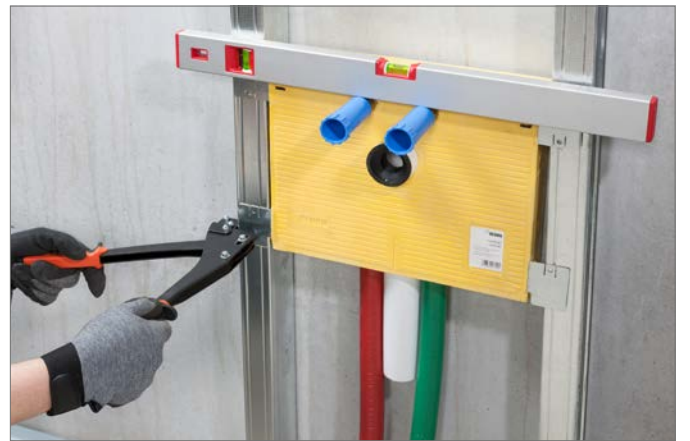
Şek. 6-37 Bağlantı kulaklarının hizalanması ve krimplenmesi
