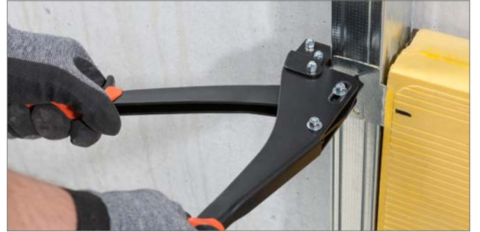
Şek. 6-36 İlk bağlantı kulağının krimplenmesi
