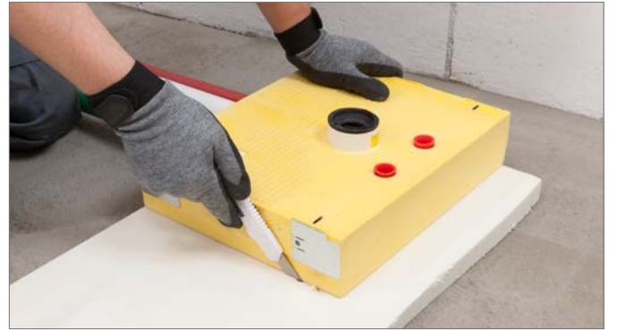
Şek. 6-45 Alternatif mesafe plakalarının kesilmesi
