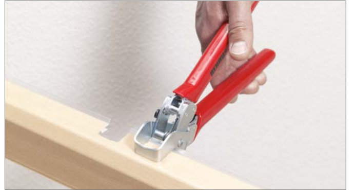
Şek. 20-33 Süpürgelik kanalı üst parçasını çözün
