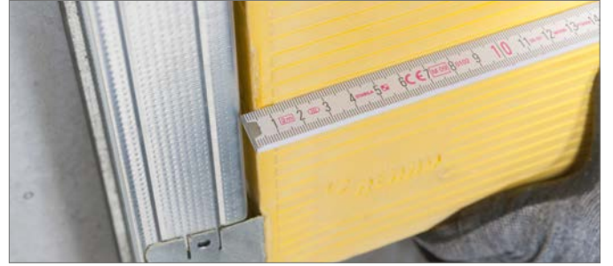
Şek. 6-35 Sıhhi kutunun alıştırılması
