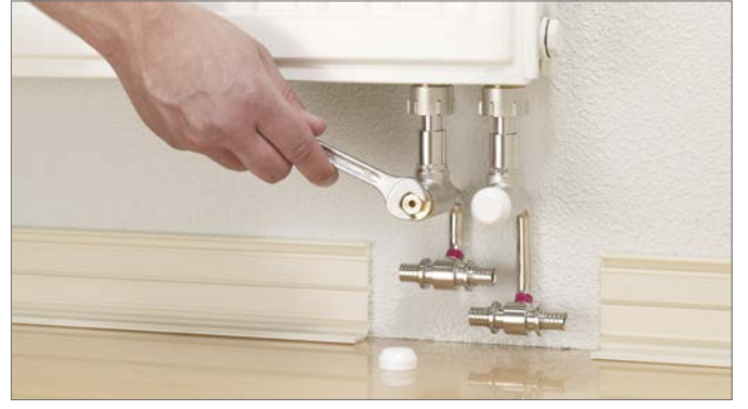
Şek. 20-39 Boru bağlantı rakorunu iyice sıkın
