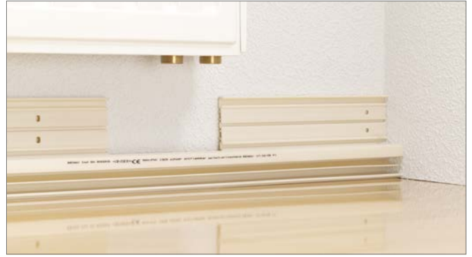
Şek. 20-37 Monte edilmiş girintili RAUDUO süpürgelik kanalı alt parçası
