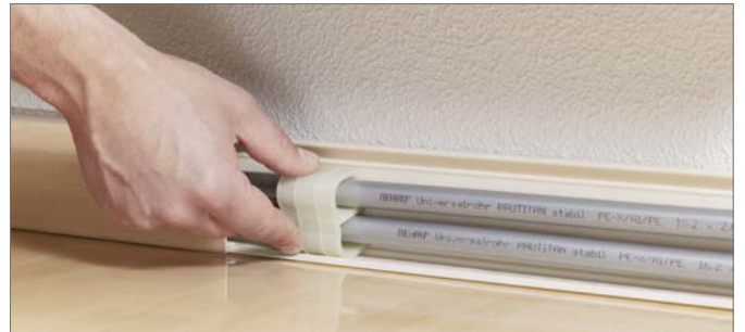
Şek. 20-30 Isıtma borusu taşıyıcısını geçirin
