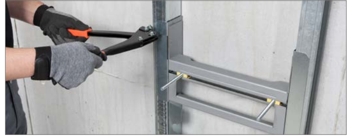
Şek. 6-40 RSB destek dirseğinin krimplenmesi
