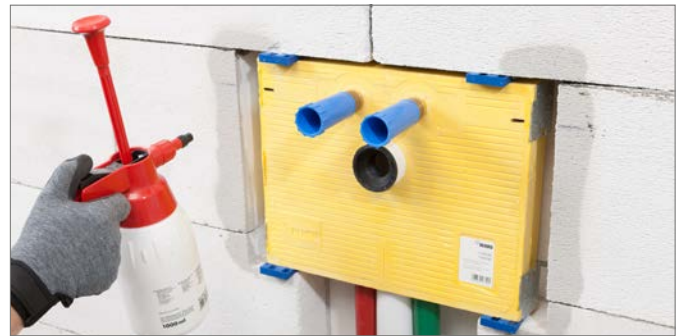
Şek. 6-54 Sıhhi kutunun ve yüzeyin nemlendirilmesi
