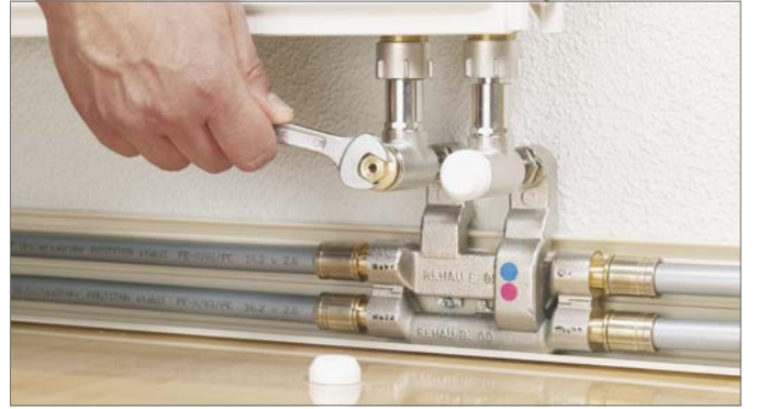
Şek. 20-32 Boru bağlantı rakorunu iyice sıkın
