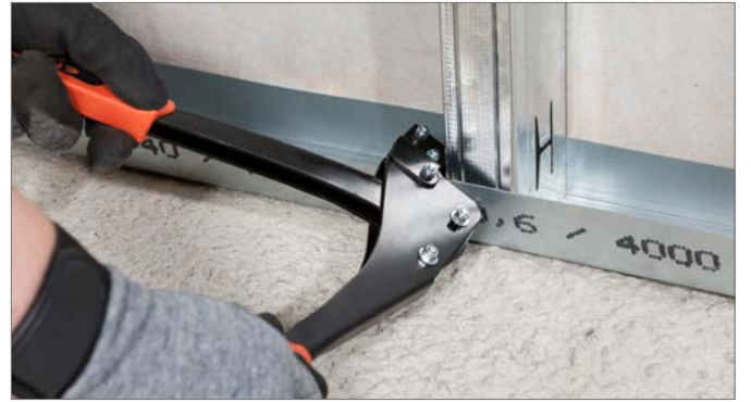
Şek. 6-32 CW profilinin UW profiline bağlanması
