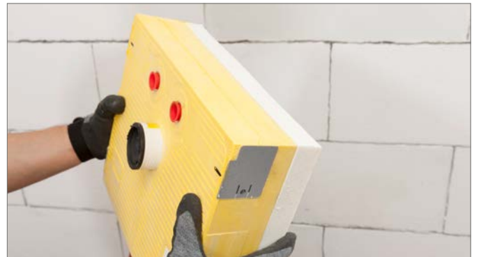
Şek. 6-46 Yapıştırmanın hazırlanması
