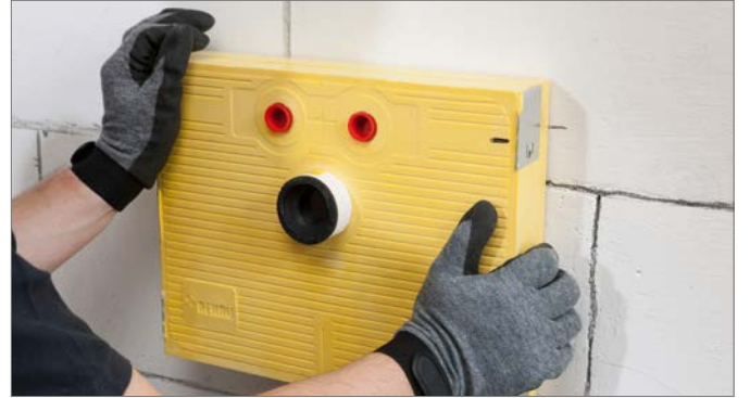
Şek. 6-49 Sıhhi kutunun yapıştırılması
