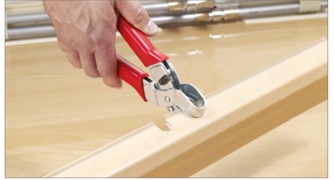
Şek. 20-40 Süpürgelik kanalı üst parçasını çözün
