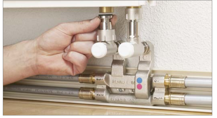
Şek. 20-31 Teleskop köşe rakor setini vanalı radyatöre bağlayın
