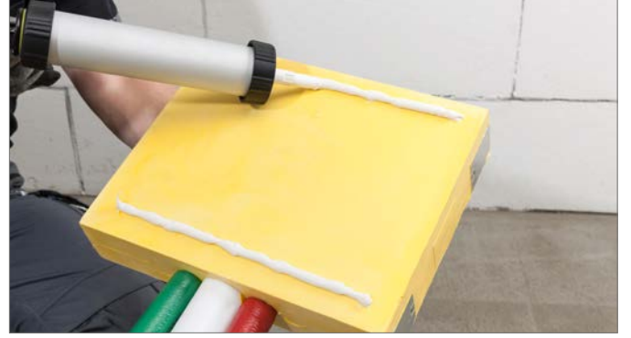
Şek. 6-48 RSB montaj tutkalının uygulanması
